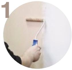
1 Нанесите с помощью валика два слоя колерованной подложки Latex Primer S. Дайте поверхности высохнуть.
