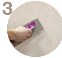
3 Затем еще через 2–4 часа нанесите металлической кельмой на небольшие участки второй слой Next. Местами должен проглядывать первый слой материала. Формируйте рисунок круговыми разнонаправленными движениями, сразу приглаживайте материал ребром кельмы, гляncуйте поверхность. При необходимости через час можно нанести локально третий слой.
