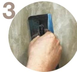
3 Еще через 2-4 часа нанесите кельмой второй слой Harvey. Сразу же сформируйте рисунок хаотичными, разнонаправленными движениями, работая то одной, то другой гранью инструмента.
