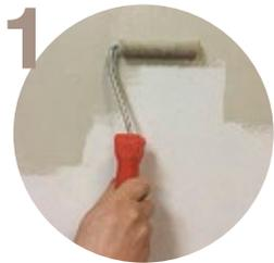
1 Нанесите с помощью валика два слоя колерованной подложки Latex Primer S. Дайте поверхности высохнуть.
